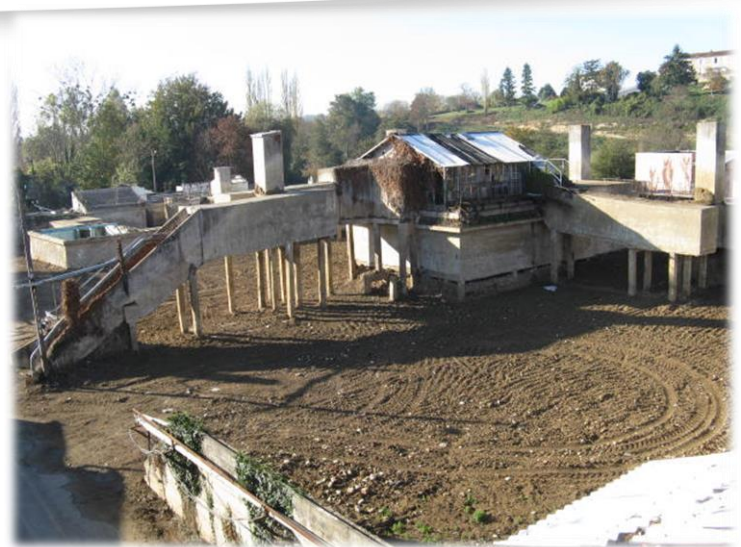
2/ démantèlement et décontamination
