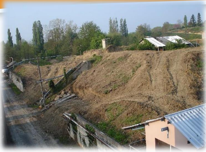
1/ Enlèvement des terres de recouvrement
